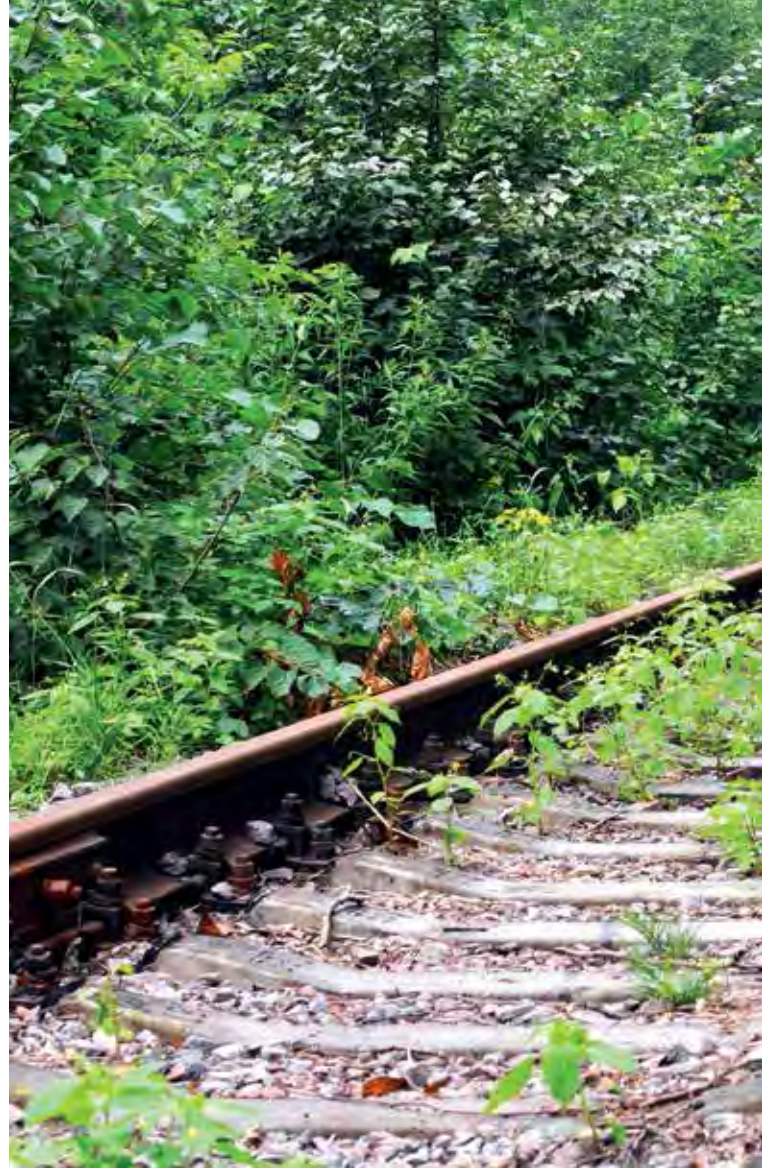
▲ Ratapenkereiden sorapäälysteet luetaan rakennus- ja purkujätteiksi. Niiden
