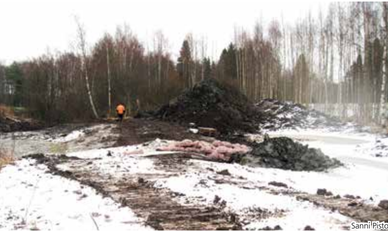
▲ Kesälahden rouhepato rakennettiin viime talvena. Tässä pato vielä rakennusvaiheessa.
